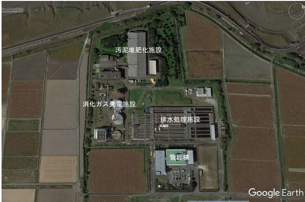
図1.1.2 佐賀市下水浄化センターの衛星画像
