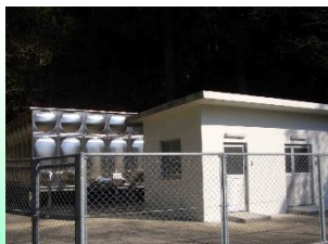
松梅北部水道施設配水池
