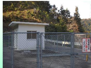
大和柚木水道施設配水池
