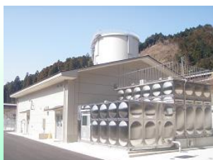
富士中央水道施設棟
