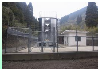
松梅北部水道施設浄水池
