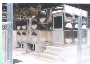
富士中央水道施設配水池(貝野地区)
