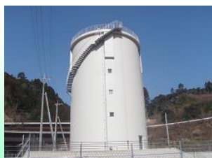
富士中央水道施設配水池
