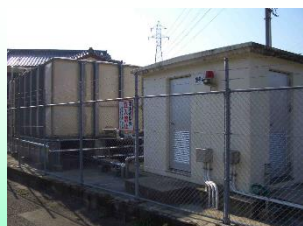
富士南部水道施設第一配水池
