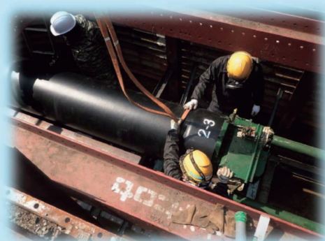
▲入れ替え工事の様子 (神園三丁目)
