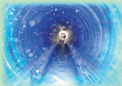
▲更生工事が完了した管の内面 (硬質塩化ビニル製 内面ライニング)
