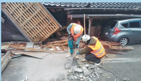
輪島市河井町 漏水復旧作業 (地面を掘り、漏水を1か所ずつ修繕していきます)
