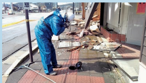
輪島市河井町 漏水復旧作業 (水漏れていないか、音を聞いている)
