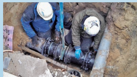
輪島市河井町 漏水復旧作業 (水漏れた水道管を切断し、つなぎ直します)
