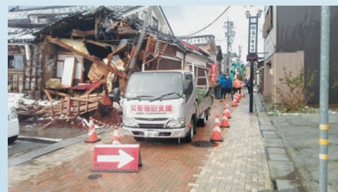
輪島市河井町 漏水復旧作業 (壊れて水漏れしている水道管を修理しています)
