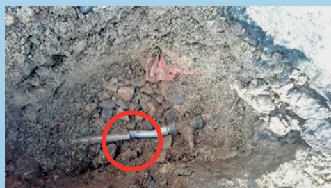
輪島市河井町 漏水復旧作業 (地震で水道メーターにつながる管が折れています)
