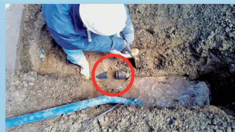
輪島市河井町 漏水復旧作業 (黒い水道管が地震で抜けてしまっています)
