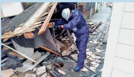
輪島市河井町 漏水調査 (水道管に少しずつ水を通し、水漏れがないか調べます)
