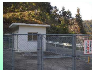
大和柚木水道施設
