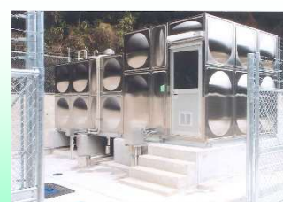
富士中央水道施設配水池(貝野地区)
