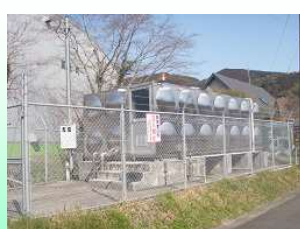
富士南部水道施設第二配水池
