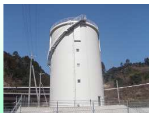
富士中央水道施設配水池
