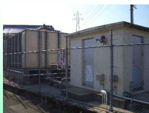
富士南部水道施設第一配水池
