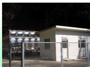
松梅北部水道施設
