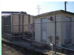
富士南部水道施設第一配水池
