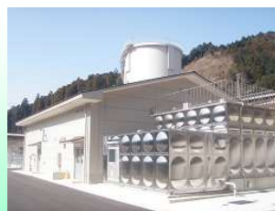
富士中央水道施設棟
