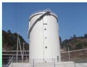
富士中央水道施設配水池
