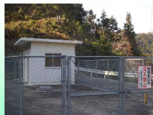
大和柚木水道施設
