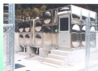
富士中央水道施設配水池(貝野地区)
